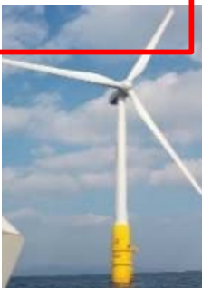
浮体式洋上風力発電 (長崎県五島市沖)
